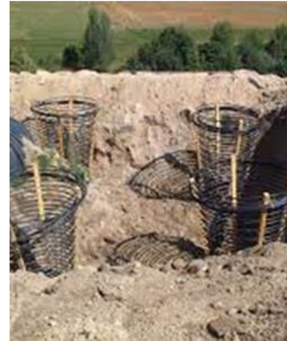
Quelle: Steinger Gebäudetechnik
