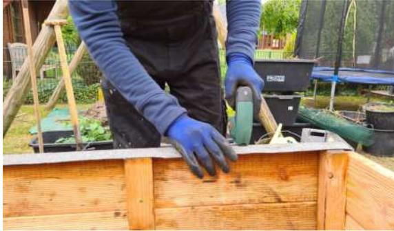
9.) Mit einem Akkutacker werden alle Seitenstreifen befestigt.
