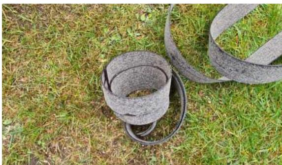
7.) Mit Mauersperrbahn-Streifen schützen wir die Unterseite des Kastens.
